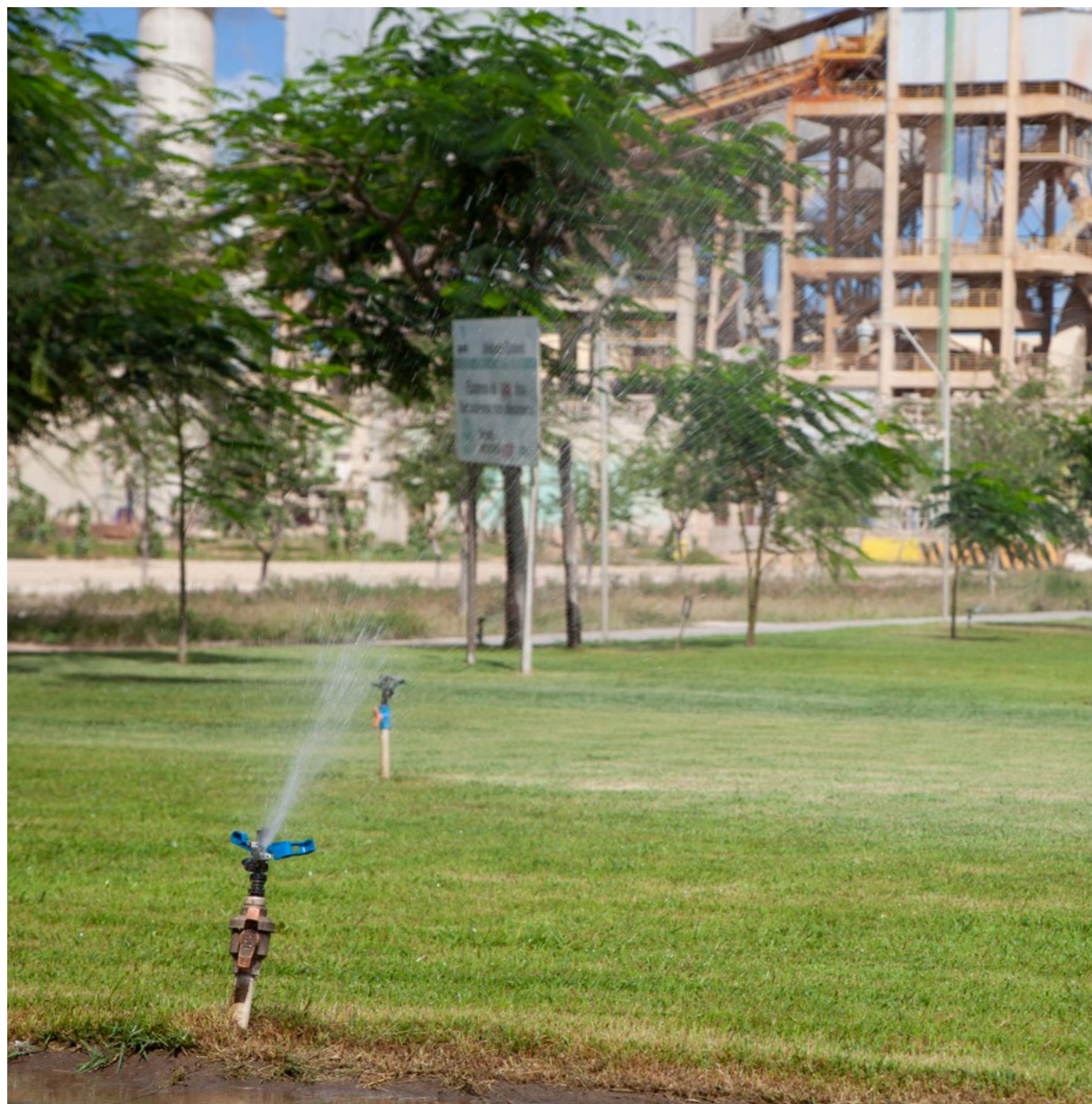
Sistema de irrigação a partir do tratamento e reúso de água.
