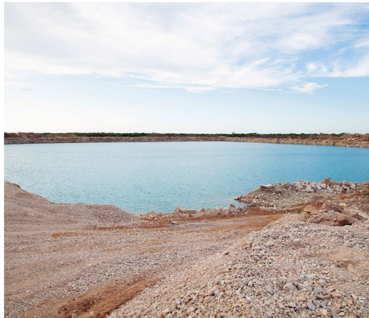
Reservatório de água captada da chuva da cava da mineração em Quixeré.
